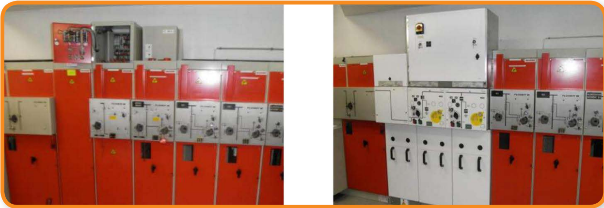
Remplacement des cellules normal / secours
